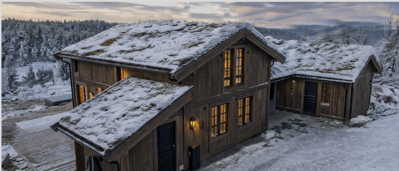
Tilsvarende hytte med påbygd ekstra bod utvendig.
